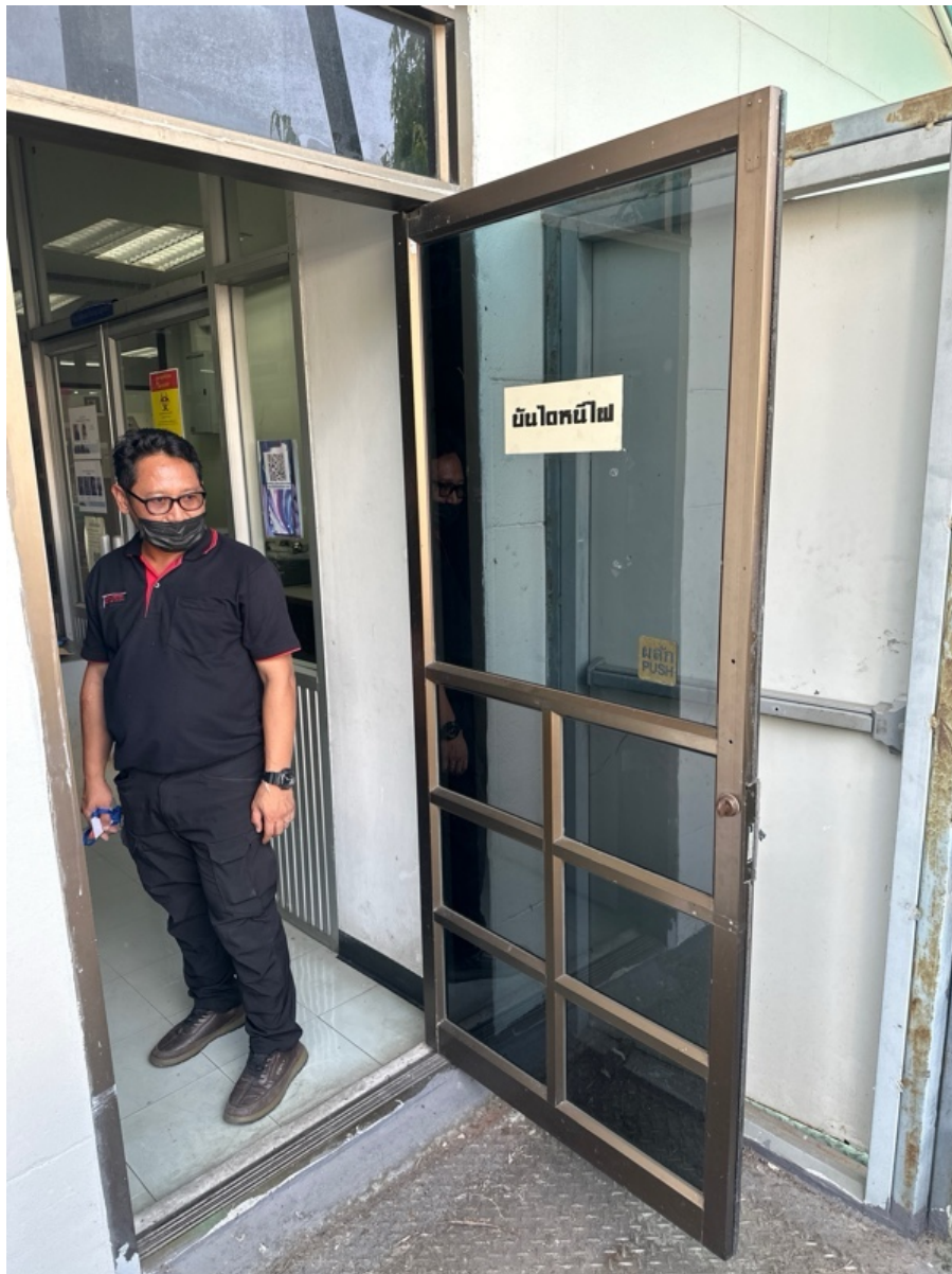
5. ควรสลับฝั่งประตู ทางออกชั้นสอง ตำแหน่งที่พบ : บันไดหนีไฟชั้นสอง
